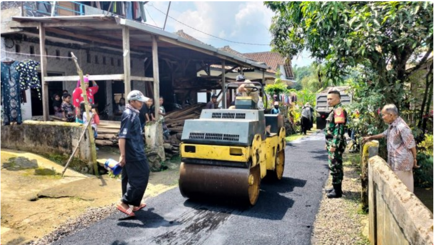
Serda Suherlan Giat Monitoring Perbaikan Jalan di Bojonglongok Kecamatan Parakansalak
