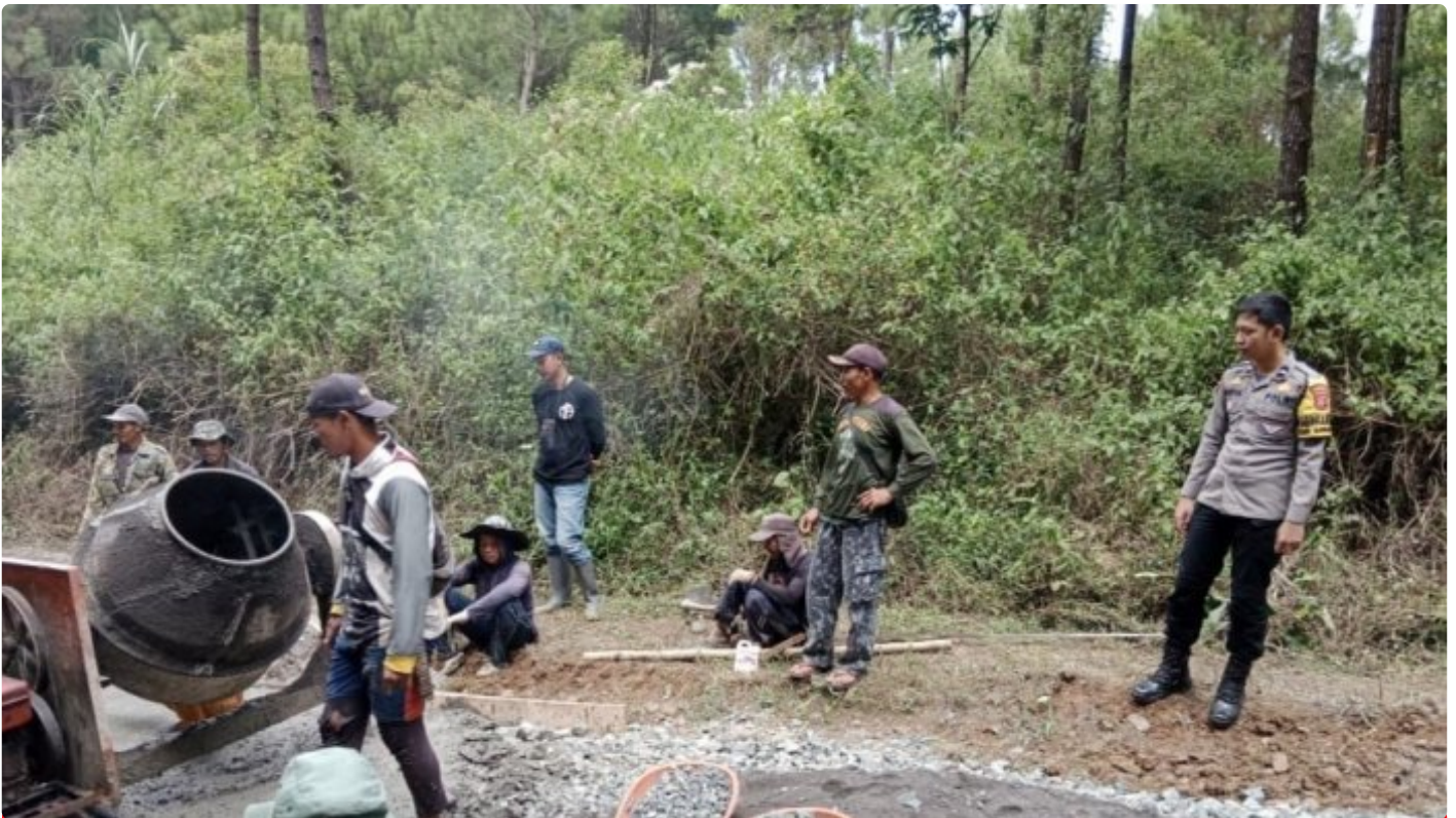
Polsek Jampang Tengah Polres Sukabumi Monitoring Pembangunan Jalan Desa
