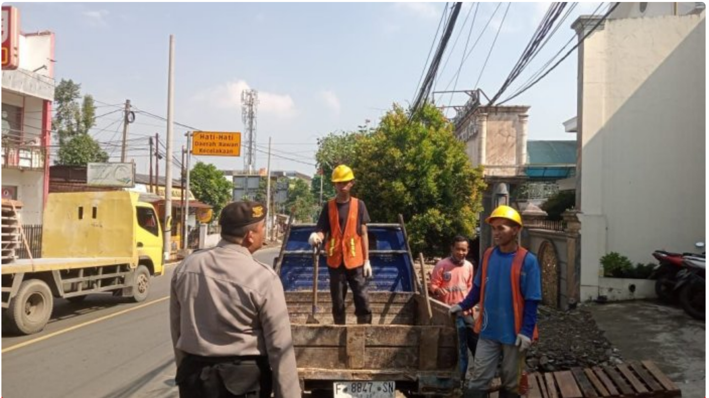
Kanit Samapta Polsek Gunungpuyuh Berikan Himbauan Kepada Pekerja Proyek Trotoar
