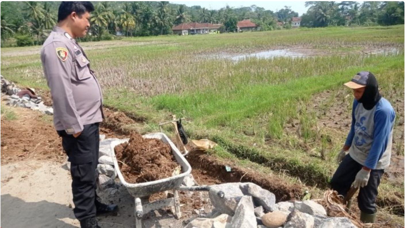
Bhabinkamtibmas Desa Tonjong, Pantau Pembangunan TPT di Desa Binaan
