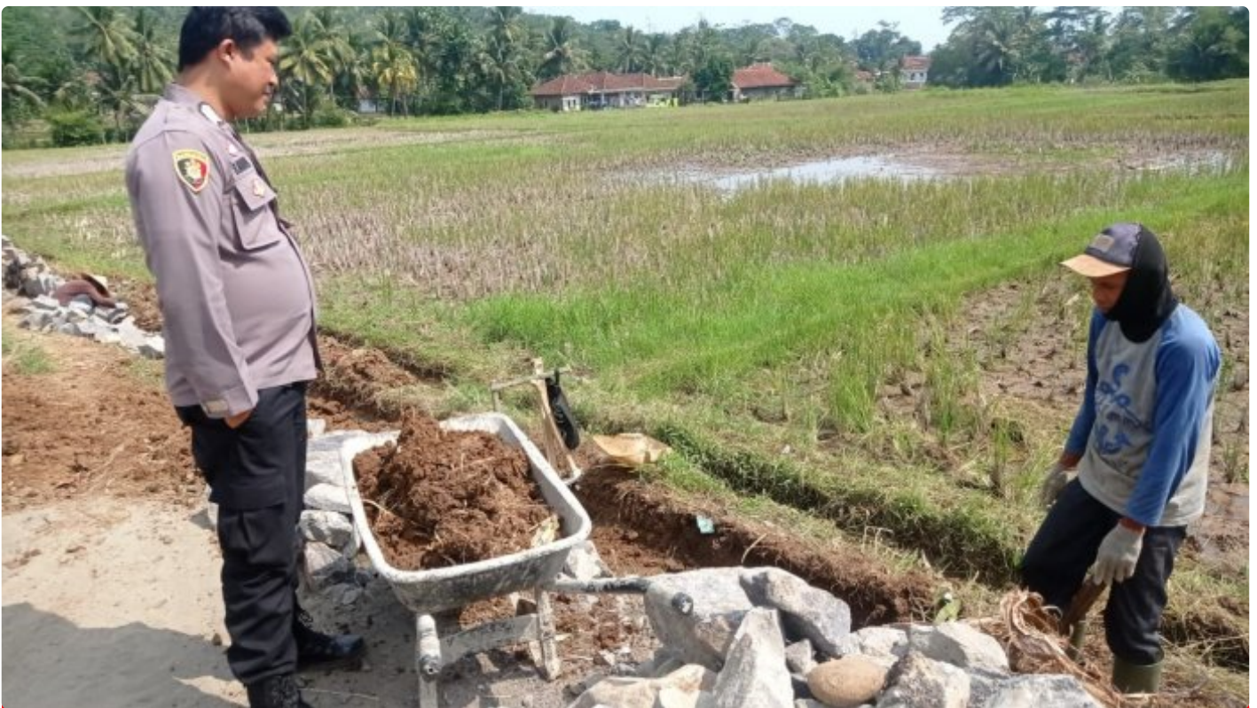
Bhabinkamtibmas Desa Tonjong, Pantau Pembangunan TPT di Desa Binaan
